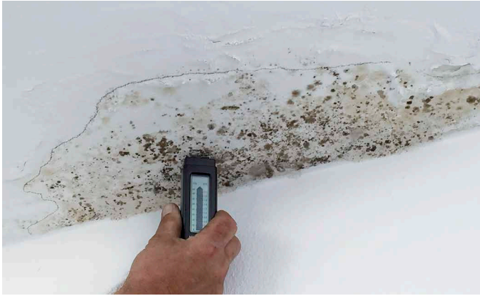
Abb. 4: Wasserprobe: Kennzeichnung der bisherigen Feuchteerscheinungen beziehungsweise deren Ausmaße. Die Feuchtemessung zeigt vollen Ausschlag (direkt neben den bisherigen Ausbreitungen zeigt die Feuchtemessung fast keinen Ausschlag). Hinweis: Wasser wird mindestens eine halbe Stunde über den Dachgully eingeleitet
