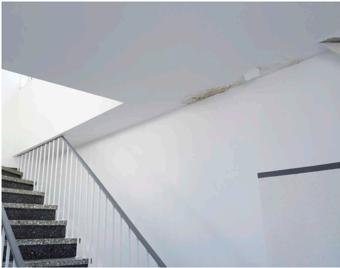
Abb. 3: Lagebild: Eingrenzung der Lage des Schadens im Verhältnis zur Dachfläche beziehungsweise zu den Dachanschlüssen. Die Außenkante liegt 15 Zentimeter versetzt, gemessen von der inneren Deckenkante
