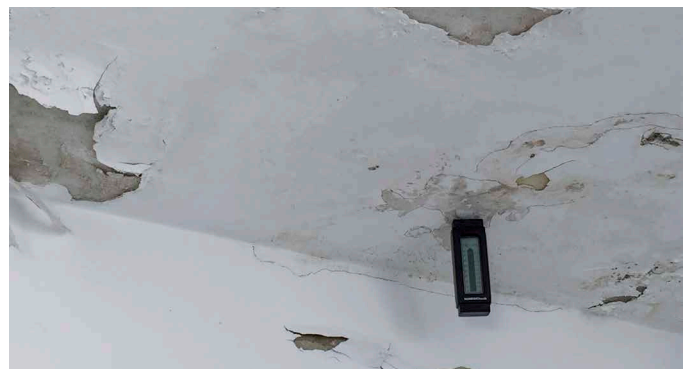
Abb. 2: Wasserprobe: Kennzeichnung der bisherigen Feuchteerscheinungen beziehungsweise deren Ausmaße
