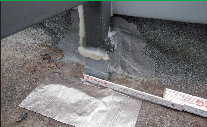
Abbildung 3. Geländerpfosten. Durchdringung der Abdichtungsebene mit dem Stützenfuß, Zu dichtes Heranführen des Stützenfußes an die aufgehende Attika
