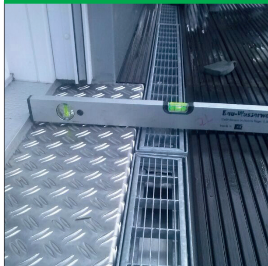
Abbildung 1: Gegengefälle der Fensterbänke und fehlende Anschlusshöhe zwischen Belag und Fenstersockel
