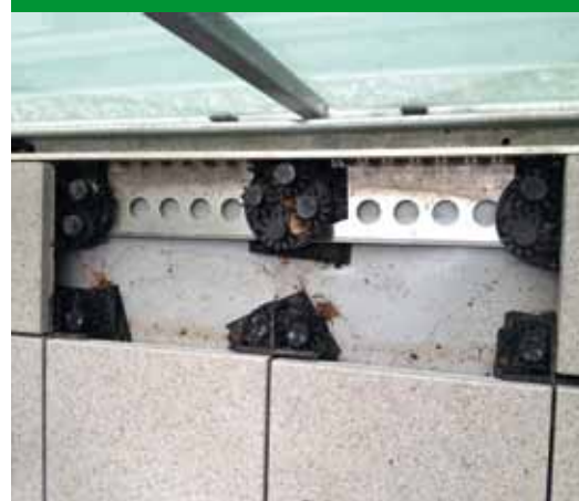
Abbildung 1: Aufständering, Alurandwinkel, Alurandwinkel
